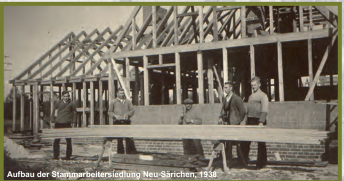
Aufbau der Stammarbeitersiedlung Neu-Särichen, 1938
