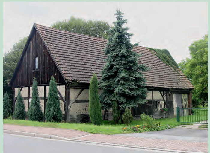
Die denkmalgeschützte Fachwerkscheune in Stannewisch sucht einen neuen Standort – Foto: Jürgen Cieslak, 2011
